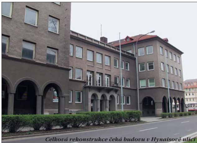
Celková rekonstrukce čeká budovu v Hynaisově ulici
